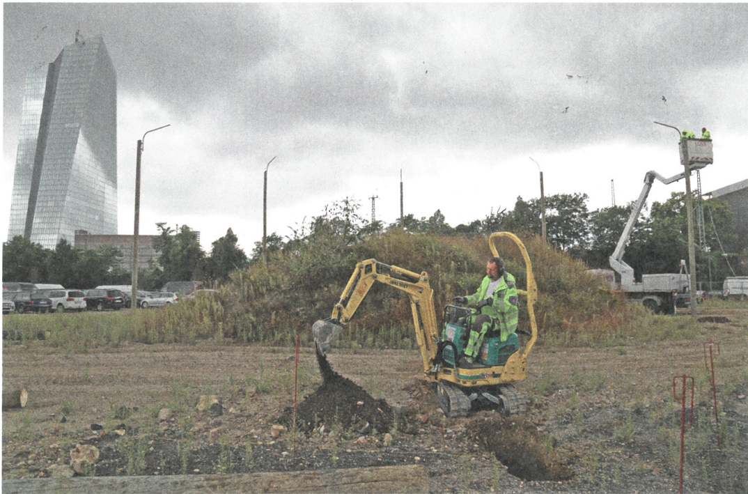
Kunst am Neubau: Installation von Nuno Ramos auf einer Brache an der EZB
